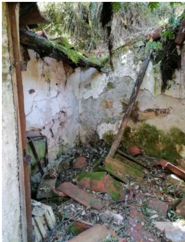
VISTA INTERNO W.C.
